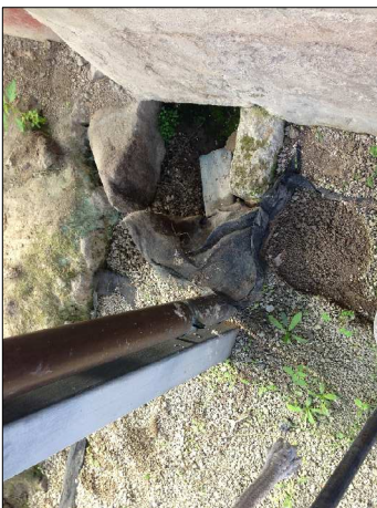
FOTO 4_Particolare del terminale del pluviale P2
