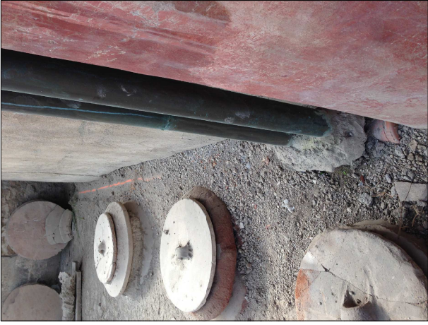
FOTO 2_Vista dei pluviali P1 e P1bis e del condotto di collegamento con la rete esterna
